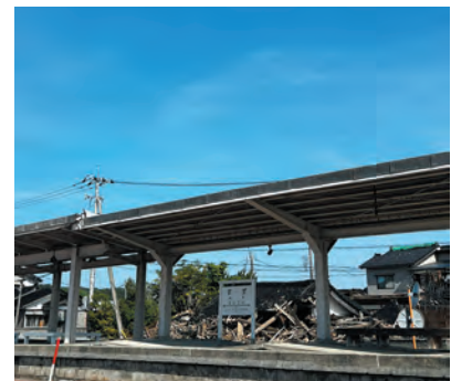
廃駅となってしまった旧能登線の「珠洲駅」。今は珠洲市道の駅「すずなり」のシンボルとなっている。珠洲市は能登半島北端に位置する。のどかな町並みのなかに、地震でぺしゃんこになった建物があちこちにある。日常と、非日常が混在する風景が印象的。
