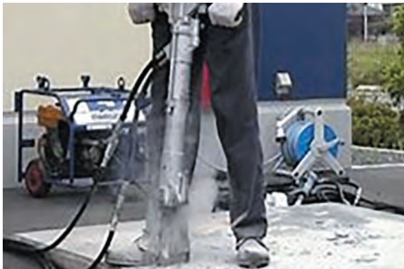
図4：RC造建物解体工事現場
